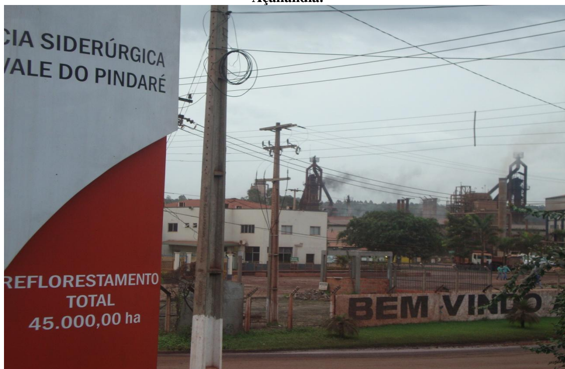
Fotografia 12 - Companhia Siderúrgica Vale do Pindaré: estrutura fabril da empresa em Açailândia.
