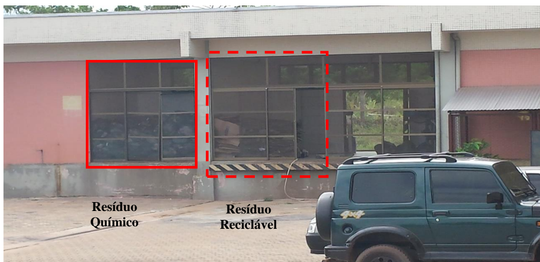
Fotografia 37 - Espaço do Abrigo externo (Central de Resíduos) para armazenamento de resíduos químicos e recicláveis gerados no HRBA.
