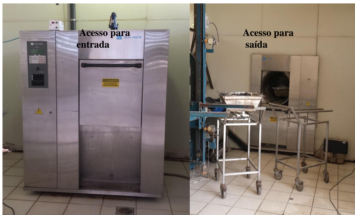
Fotografia 35 - Autoclave da Central de Resíduos do HRBA.
