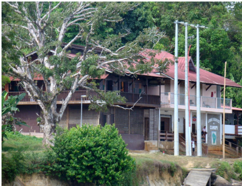
Fotografia 45: Armazém de Camopi/GF Fonte: Cruz (2009).
