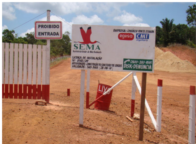
Fotografia 34: Canteiro de Obras da ponte. Fonte: Cruz (2009).
