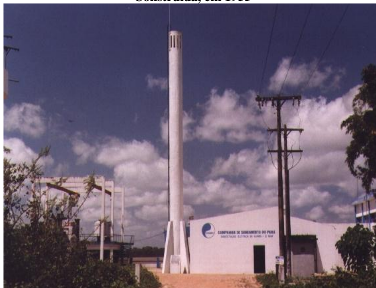
Fotografia1- Primeira estação de captação de água bruta do Rio Guamá Construída, em 1955
