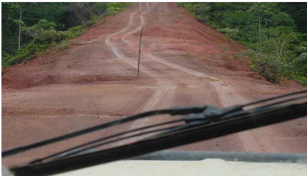
Foto 25: Acesso ao PA da Perimetral Norte (BR-210). Fonte: Foto cedida pelo técnico da FUNASA Paulo Vieira.
