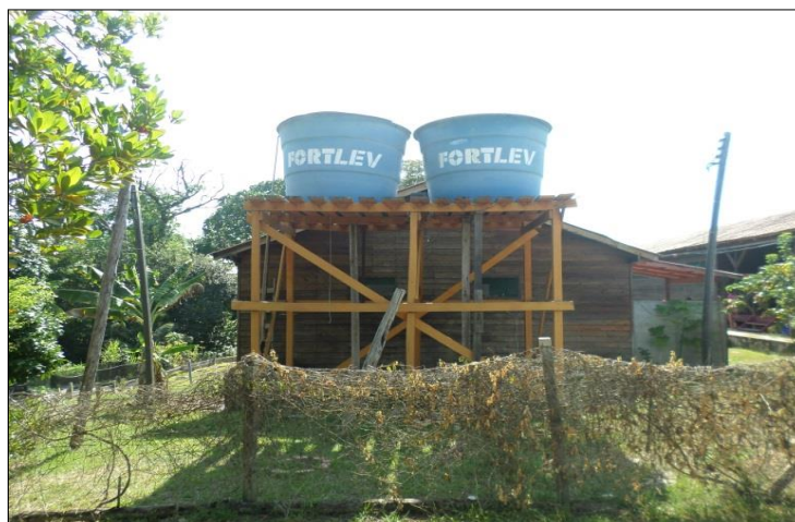
Fotografia 13- Reservatórios de água.
