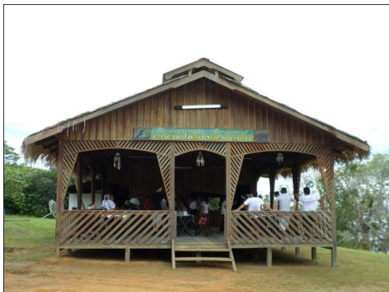
Fotografia 30- Restaurante Recanto do Saracá.
