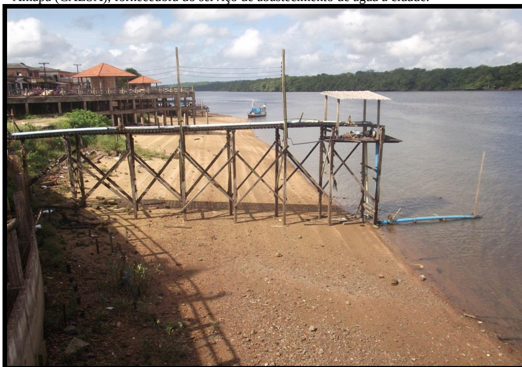
Fotografia 9 - Esta foto demonstra por onde é coletada a água que entra nas torneiras da população. A empresa responsável: Companhia de Água, Esgoto e Saneamento do Amapá (CAESA), fornecedora do serviço de abastecimento de água à cidade.
