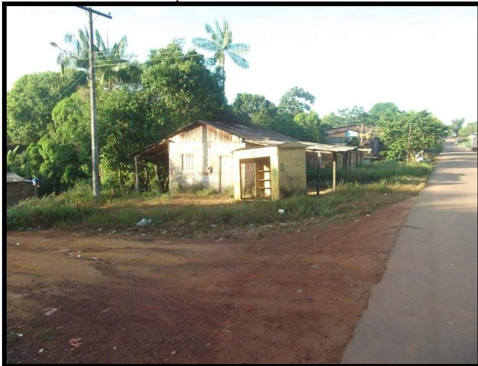
Fotografia 7 - Cruzamento entre uma das ruas e travessa da cidade. Demonstra o asfaltamento incompleto.
