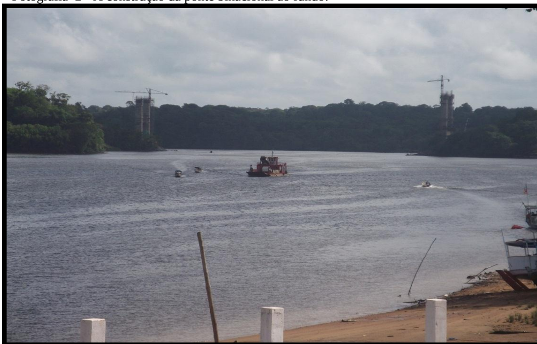
Fotografia 2 - A construção da ponte binacional ao fundo.
