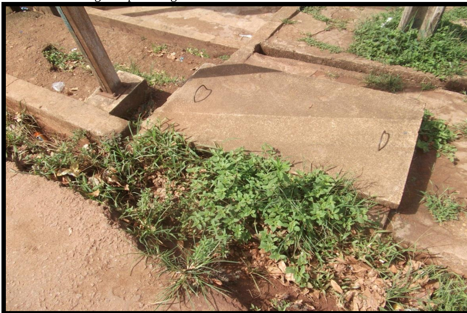
Fotografia 3 - Foto de uma das principais vias de Oiapoque. Essa retrata um dos poucos locais onde há algum tipo de esgoto.
