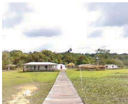
Fotografia 16 - Trapiche na Comunidade de Santo Antonio de Carmelino. Fonte: Costa (2008).
