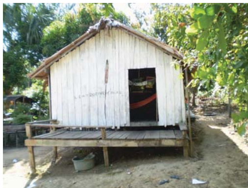
Fotografia 8 - Residência na comunidade de Arimum. Fonte: Costa (2008).
