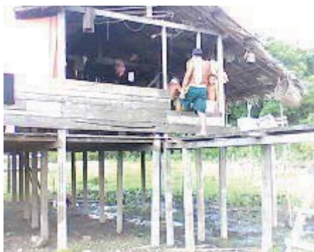
Fotografia 17 - Residência na Comunidade de Santa Clara . Fonte: Costa (2008).
