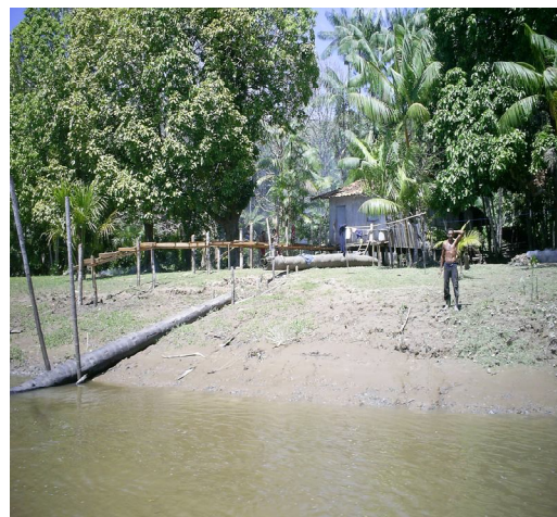
Fotografia 7 - Ponte feita de tronco de árvore de miriti na localidade de Beira de Rio
