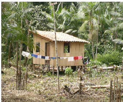
Fotografia 41 - Residência recém-construída de família em expansão no povoado do Cruzeiroinho
