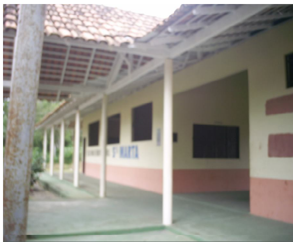
Fotografia 11 - Escola no povoado da Vila
