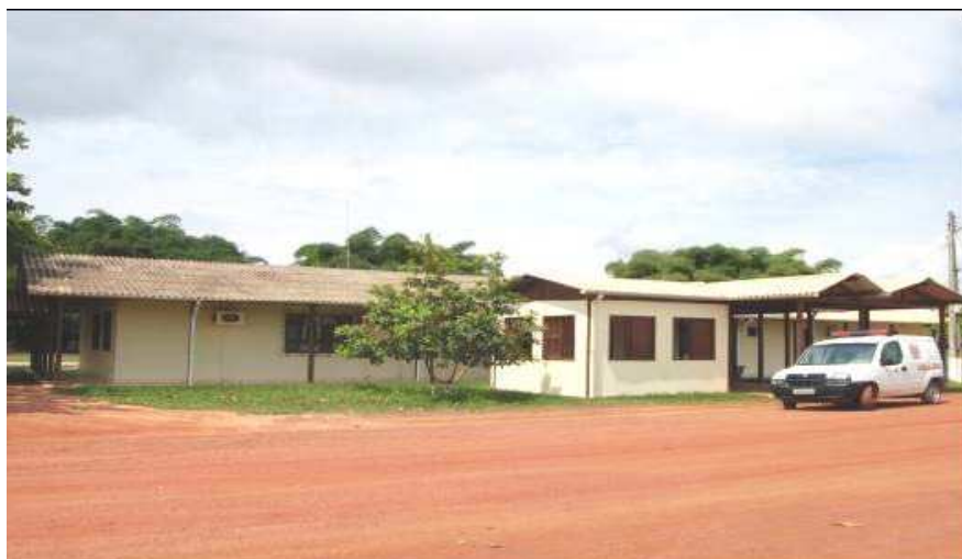
Figura 55: Ambulatório do Complexo Agroindustrial.
