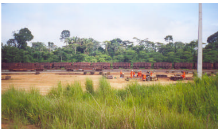
Foto 11: Duplicação da Estrada de Ferro Carajás, com a utilização de mão-de-obra assentada, 28/09/05.
