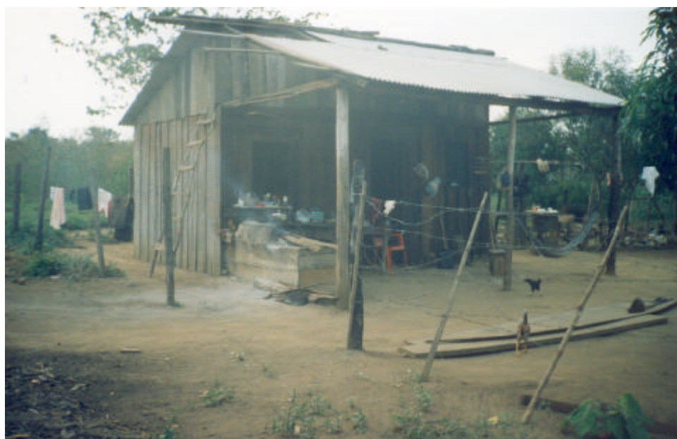
Foto 6: Estruturas de casa no lote do PA Carlos Fonseca, 28/09/03.
