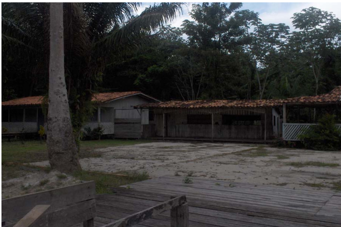
Figura 12: Prédios da escola, da barraca de comidas e do centro comunitário de Piriquitaquara Fonte: Pesquisa de campo, 2006
