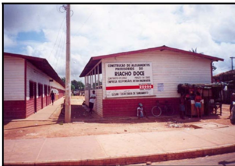
Foto 16: Alojamentos provisórios do Riacho Doce Construídos para abrigar as vítimas do incêndio, estes tinham as características das maquetes apresentadas pelo PDL Fonte: Charles B. Gemaque Souza (Mar-2002)
