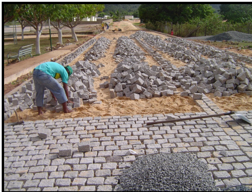
Fotografia 9 – Asfaltamento das ruas da sede do município de Uiramutã.
