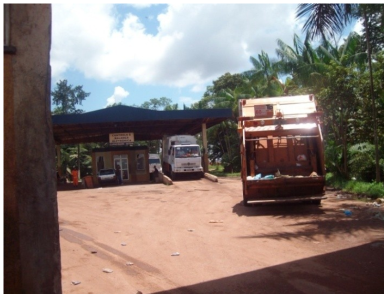
Fotografia 9: : Balança de pesagem dos caminhões coletores na entrada do Aterro Sanitário do Aurá, na saída. Foto: Tatylene Freire (2010)
