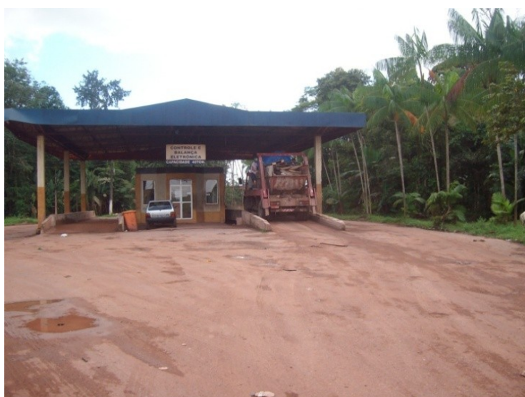
Fotografia 8: Balança de pesagem dos caminhões coletores na entrada do Aterro Sanitário do Aurá, na entrada. Foto: Tatylene Freire (2010)
