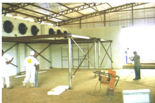
Figura 23 - Obras de ampliação da fábrica: da construção de uma nova câmara fria. Fonte: foto tirada pelo autor.
