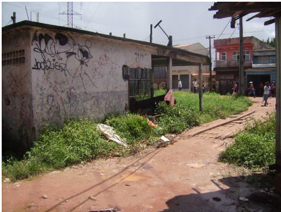
Fotografia 5- PM Box destruído na passagem Ligação (Terra Firme). Fonte: Couto (2010).
